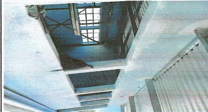
Foto 2: Cambio de costaneras.
